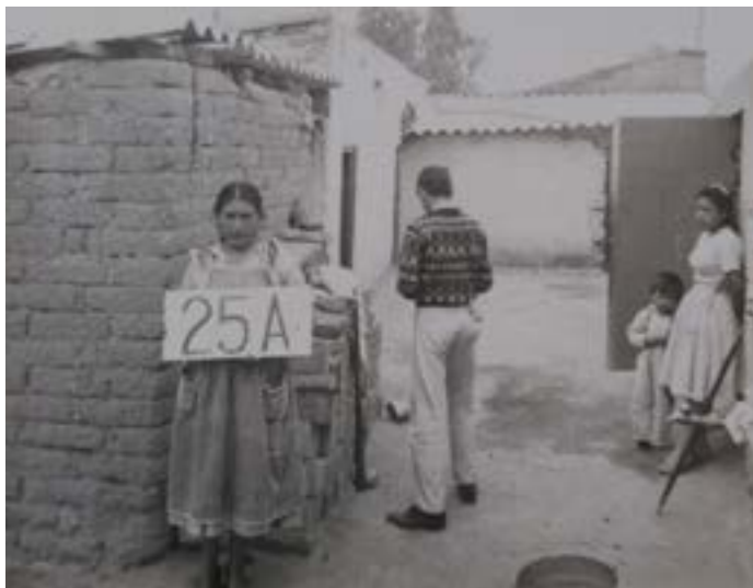
Fig. 3. Propiedad expropiada para construcción de Emisor Poniente. AHA, Fondo Aguas Nacionales, Caja 3859, EXP. 62130, FOJA 9.
